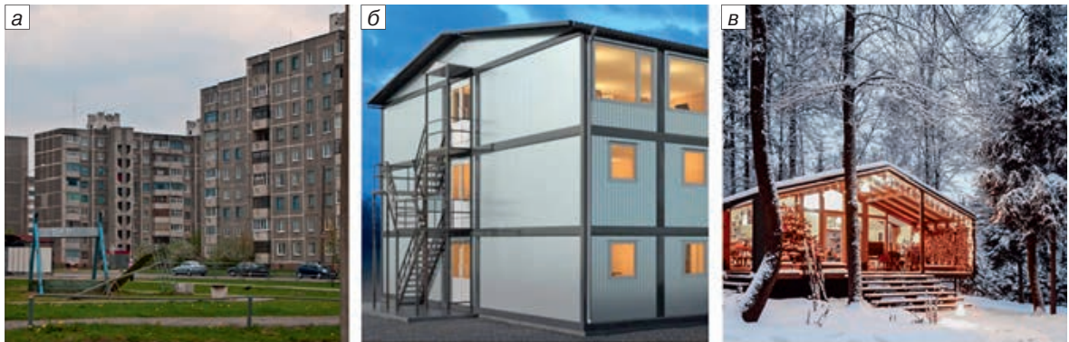
Иллюстрация 11. Модульное строительство: а — панельное домостроение (источник: https://macos.livejournal.com/427453.html ); б — модульное вахтовое здание (источник: https://archstroy.su/article/66 ); в — модульный дубльдом (источник: https://dubldom.com/ekb )
