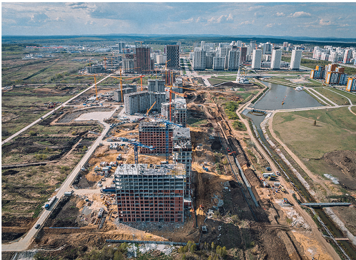
Иллюстрация 1. Фото строительства 12 и 16 кварталов в районе «Академический-2», 2022 г., АО Специализированный застройщик «РСГ-Академическое» (ГК «КОРТРОС»)
