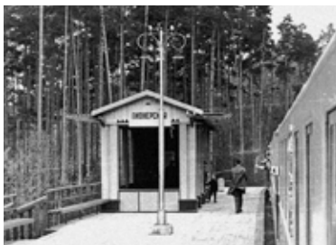
Иллюстрация 8. Станция «Пионерская», 1970-е гг. Источник: музей истории, науки и техники Свердловской железной дороги
