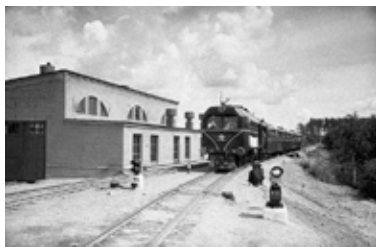
Иллюстрация 4. Здание локомотивного депо на станции «Центральная», 9 июля 1960 г. Источник: ГАСО
