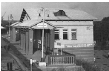
Иллюстрация 1. Боковой фасад вокзала станции «Центральная» со стороны привокзальной площади, 1964 г. Источник: музей истории, науки и техники Свердловской железной дороги
