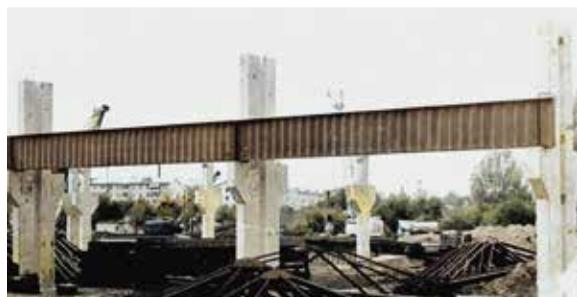
Иллюстрация 1. Подкрановые балки с гофрированной стенкой пролетом 12 м в процессе монтажа. Фото: 1980-е гг. Автор Ю. С. Максимов [5]
