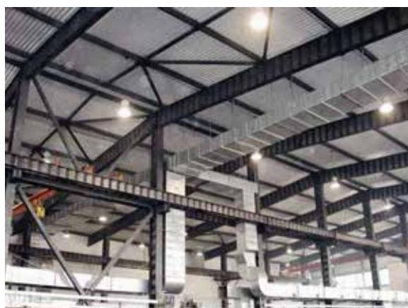
Иллюстрация 2. Каркас производственного здания, выполненный из конструкций с гофрированной стенкой. Подкрановые балки пролетом 6 м. Фото: 1990-е гг. Автор Ю. С. Максимов [5]
