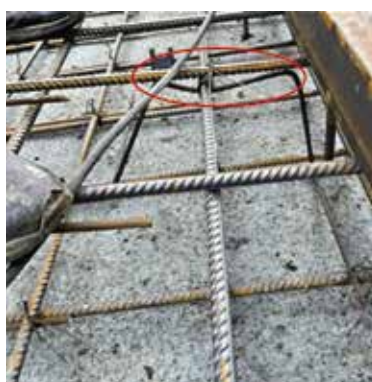
Иллюстрация 9. Смятие фиксаторов верхнего ряда армирования плиты
