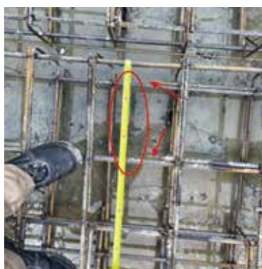
Иллюстрация 5. Превышение проектного шага арматуры
