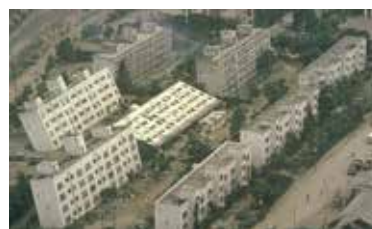
Иллюстрация 1. Последствия землетрясения в г. Ниигата, Япония. 1964 г.
