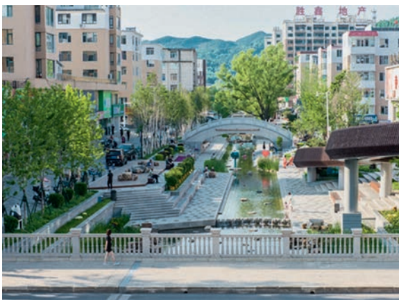
Иллюстрации 4, 5. Многоуровневая планировка береговых зон дает возможность затопления нижних ярусов, не препятствуя эксплуатации объекта. Фотограф Li Kuan. [9]
