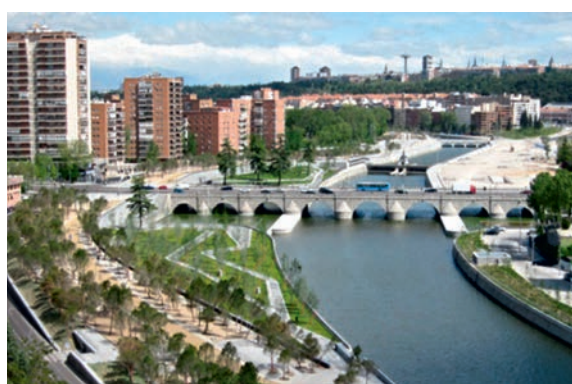
Иллюстрация 7. Состояние набережной реки Мансанарес после ренатурализации [10]
