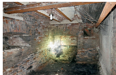
Иллюстрация 3. ОКН федерального значения «Дом, в котором находился штаб областного комитета РСДРП(б)» во главе с Малышевым, Вайнером и Хохряковым». г. Екатеринбург, ул. Малышева, д. 46. Перекрытие над подвалом выполнено в 1890-е гг. Шаг балок 800...900 мм. Толщина свода «в полкирпича» — 120 мм. Стрела свода 120 мм. Стальные балки перекрытия сечением из прокатных рельсов типа Р33. Пролет 6 м. Фото С. В. Кудрявцева. 2023 г.
