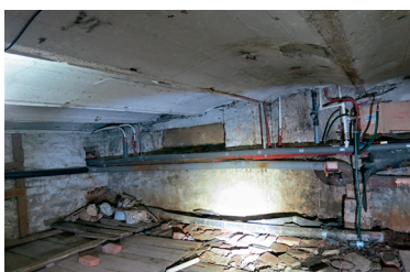
Иллюстрация 7. ОКН регионального значения «Комплекс жилых зданий (конструктивизм)». г. Екатеринбург, пр. Ленина, д. 5. Перекрытие над подвалом по бетонным сводам на стальных балках выполнено в 1929 г. Шаг балок 800...900 мм. Толщина свода — 120 мм. Стрела свода 120 мм. Стальные балки перекрытия сечением из прокатных рельсов типа Р33. Пролет 5 м. Фото С. В. Кудрявцева. 2024 г.
