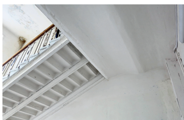
Иллюстрация 6. ОКН регионального значения «Гимназия женская». г. Екатеринбург, ул. Антона Валека, д. 11. Перекрытие лестничных площадок по бетонным сводам на стальных балках выполнено в 1935 г. Шаг балок 800...900 мм. Толщина свода — 120 мм. Стрела свода 120 мм. Стальные балки перекрытия сечением из прокатных двутавров № 24. Пролет 4,3 м. Фото С. В. Кудрявцева. 2021 г.
