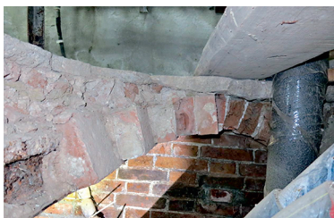
Иллюстрация 5. ОКН регионального значения «Особняк Д. А. Бахарева». Свердловская область, с. Байкалово. Зондаж перекрытия над подвалом. Пролет кирпичных сводов 800...900 мм. Толщина свода «в полкирпича» — 120 мм. Стрела свода 120 мм. Стальные балки перекрытия сечением из прокатных рельсов по типу Р33. Фото С. В. Кудрявцева. 2023 г.
