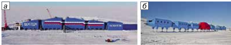
Иллюстрация 8. Криптоклиматические комплексы, образованные блокировкой конструктивно независимых объемов, в современных проектах: а — Антарктическая научная станция «Восток», Антарктида. Арх.: ОАО «Запсибгазпром». 2024 г.; б — антарктическая научная станция Халли VI, Антарктида. Арх.: Hugh Broughton Architects. 2013 г. Источники: https://moya-planeta.ru/upload/images/xl/74/f6/74f614ca19b3f7810bdd314d0eca7d54fe4a2419.jpg ; https://i.pinimg.com/originals/eb/8e/f9/eb8ef9c47f0884ca4913a72b5c07d0eb.jpg (дата обращения: 15.01.2026)
